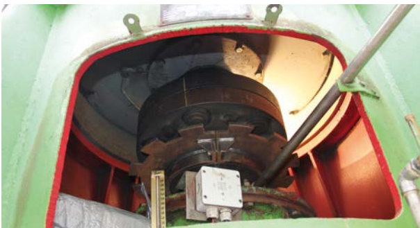
Anspruchsvolle Nachrüstung durch beengte Platzverhältnisse Demanding retrofit due to narrow spaces
