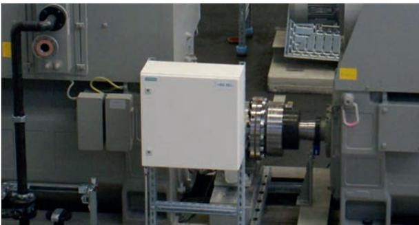
Kein freies Wellenende an Verbindungswelle zwischen Tandemmotoren
